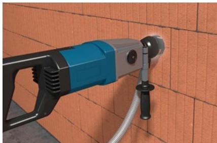
Erste Dose anzeichnen und mit 82 mm Bohrkronen ausbohren
