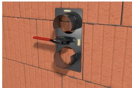
Bohrschablone einsetzen, mit Schablonenhebel mit Schnellspannfunktion befestigen und ausrichten.
