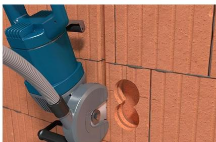
Schlitz mit Fräse neben Bohrungen fräsen, zusätzlich in die Dosenbohrung fräsen.
