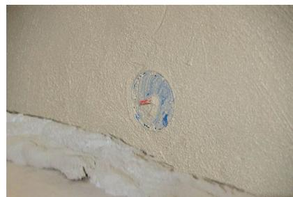
Der Putzer drückt beim Verputzen den Deckel auf die benötigte Höhe – garantiert putzbündig und VDE konform!
