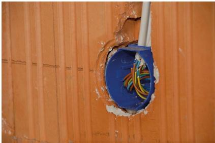
Unterteil bündig setzen, Kabel oder Rohre einführen.
