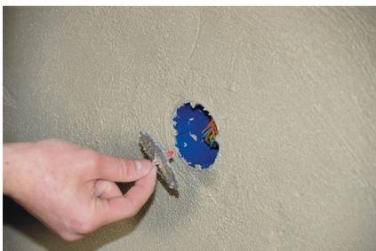
Putzfeder entfernen und mithilfe des Zentrierbohrlochs Dosendeckel ausfräsen.
