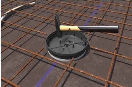
Frontteil mit Mineralfaserplatte auf Schalung nageln. Die integrierte Nagelfixierung im Frontteil ermöglicht eine einfache Montage.
