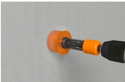
Dosenfräser im Zentrierbohrloch ansetzen und Loch ausfräsen.
