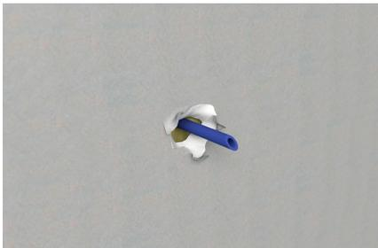
Angeschrägten Dorn durch zweite Gipskartonplatte drücken, ggf. vorher mit Hammer Loch einschlagen.
