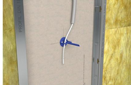
Leitungsträger auf Trockenwand befestigen und Leitungen oder Rohre durch Bügel führen.
