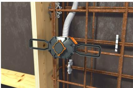
Variante 2: Aufsteckbare Flügel auf Membrandose stecken und mit Draht an Stahlarmierung befestigen.
