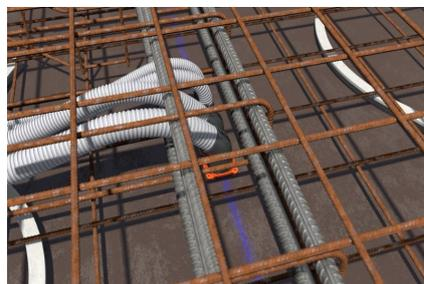
Werkzeuglose Rohreinführung M32-M40. Krümmer und Tüllen auf das Frontteil stecken. Ideal für Einbausituationen mit viel Bewehrung.
