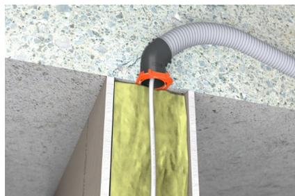
Für Installation in Leichtbauwänden geeignet und Weiterführung von Installationsrohren möglich.
