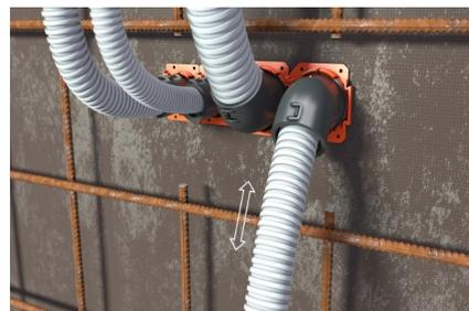
Dank Rohrgrip sicher zugentlastet und absolut betondicht.
