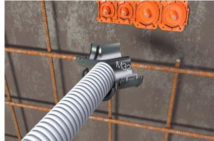
Krümmer öffnen und M32 Installationsrohr befestigen. Oder...
