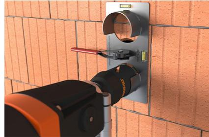
Ggf. weitere Löcher bohren. Dafür Bohrschablone einsetzen und mit Schablonenhebel mit Schnellspannfunktion befestigen sowie ausrichten.
