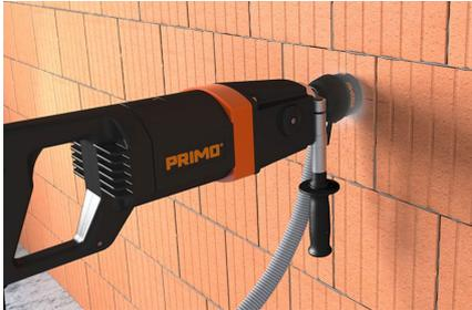
Erste Dose anzeichnen und mit 82 mm Bohrkronne ausbohren. Bei WDVS-Installationen empfehlen wir einen Bohrdurchmesser von 74mm.
