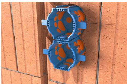
Therm Dosen mit 71mm Kombinationsabstand fest verbinden und ins Bohrloch einsetzen.
