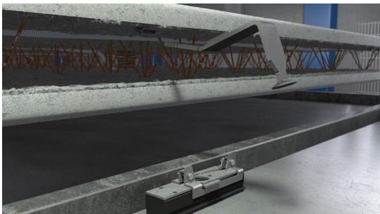
Schwert wird aus der einbetonierten Kappe herausgezogen.
