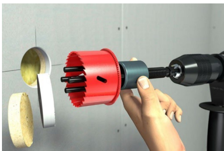
Aluminiumhülse festhalten und Bohrkern durch Linkslauf der Bohrmaschine auswerfen lassen.
