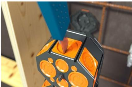
Membrane mit einem Cuttermesser öffnen.
