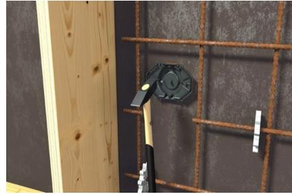
Deckel auf die Schalung nageln. Die integrierte Nagelfixierung ermöglicht eine einfache Montage.
