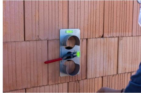
Bohrschablone einsetzen und ausrichten. Wasserwaagen sorgen für eine genaue Installation.
