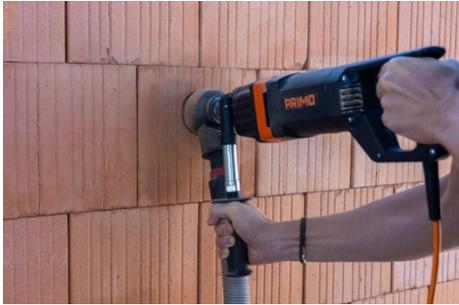
Erstes Loch ausmessen und mit Primo Schnellläufer ausfräsen.
