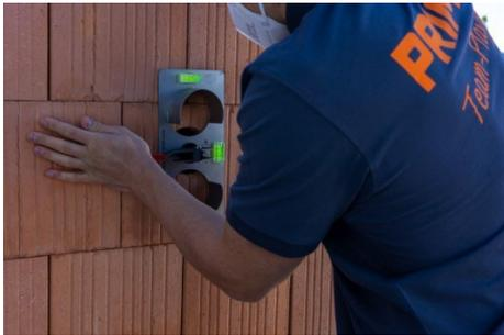
Schablonenhebel mit Schnellspannfunktion befestigen.
