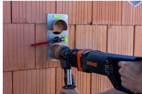
Schnellläufer mit einer  $\varnothing$  82 mm Bohrkronen gerade in Bohrschablone einsetzen und weitere Bohrlöcher ausfräsen. Es wird kein Zentrierbohrer benötigt!
