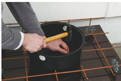
Im Ortbeton: Flex Kompakt auf Schalung Nageln.
