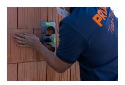
Schablonenhebel mit Schnellspannfunktion befestigen.
