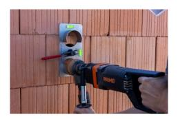
Schnellläufer mit einer Ø 82 mm Bohrkrone gerade in Bohrschablone einsetzen und weitere Bohrlöcher ausfräsen. Es wird kein Zentrierbohrer benötigt!
