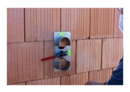
Bohrschablone einsetzen und ausrichten. Wasserwaagen sorgen für eine genaue Installation.
