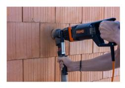
Erstes Loch ausmessen und mit Primo Schnellläufer ausfräsen.
