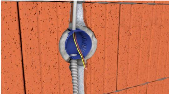
Bohrloch für Dosenunterteil fräsen. Dosenunterteil bündig setzen, Leitungen und Rohre einführen.
