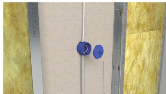
Bohrdeckel (P003) aufstecken und Dämmwolle einlegen.
