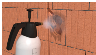
Dosenbohrung leicht anfeuchten, damit Schaum schneller aufquillt.
