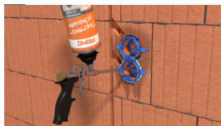
Schaum einsprühen: Wärmebrückenfreie/luftdichte Installation.
