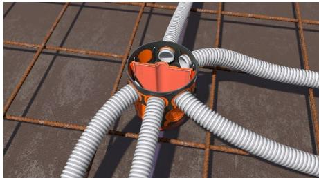
Trennsteg vor der Betonage in die Dose stecken.
