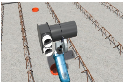
Lüftungsverteiler auf passende Länge kürzen.
