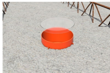
Schutzdeckel der Lüftungshülse entfernen.
