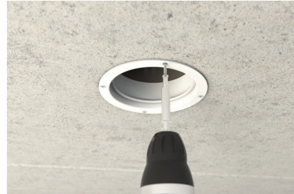
Adapterring an die Lüftungshülse schrauben.
