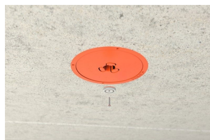
Wiederverwendbaren Magnet entfernen.
