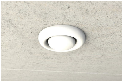
Lüftungsauslässe montieren. Durch integrierte und genormte Schraubdome auch andere Auslassformen möglich.
