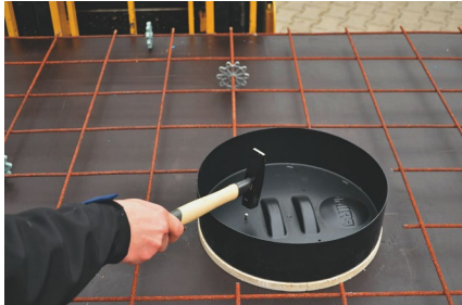
Variante 1 Im Ortbeton Kompakt: auf Schalung nageln
