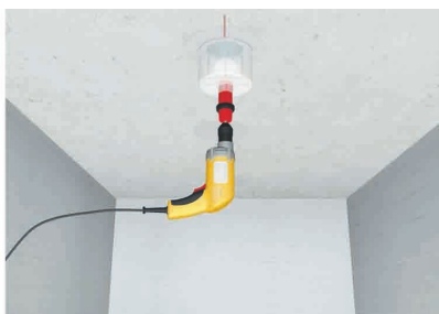
Mit einem Dosenbohrer wird die individuelle Öffnung ausgebohrt..
