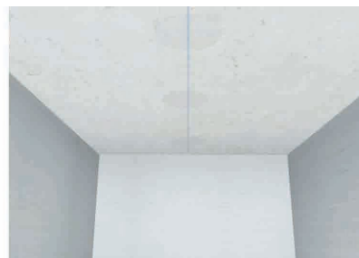
Fluchtlinie anzeichnen, Ungenauigkeiten können jetzt korrigiert werden.
