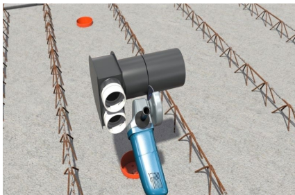
Lüftungsverteiler auf passende Länge kürzen.
