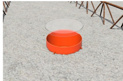
Schutzdeckel der Lüftungshülse entfernen.
