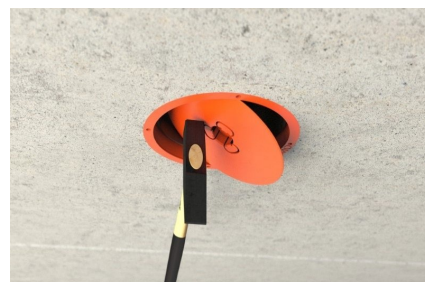
60 mm Magnet entfernen und Deckel durch einen Hammerschlag öffnen.
