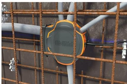
Membraneinführungen mit einem Cuttermesser öffnen. Kabel oder (starre) Rohre M9 - M40 einführen. Die Membrantechnik gewährt eine absolut betondichte Installation.
